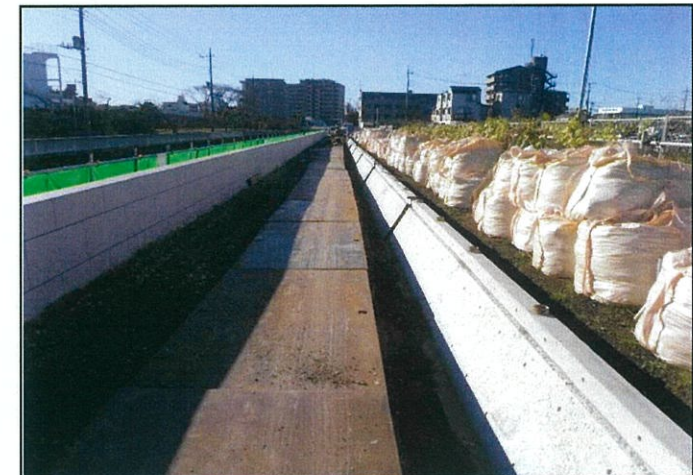
埋め戻しに使用する現場発生土の仮置き状況
